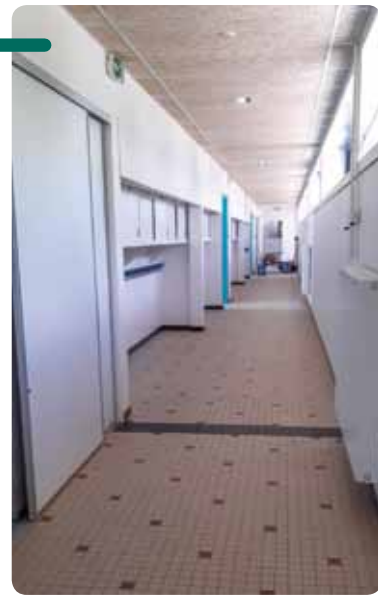
Couloir dans la partie école élémentaire.
