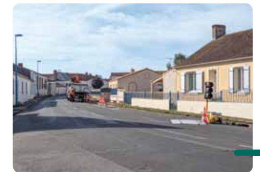
Mise en place d'une circulation alternée le temps des travaux.
