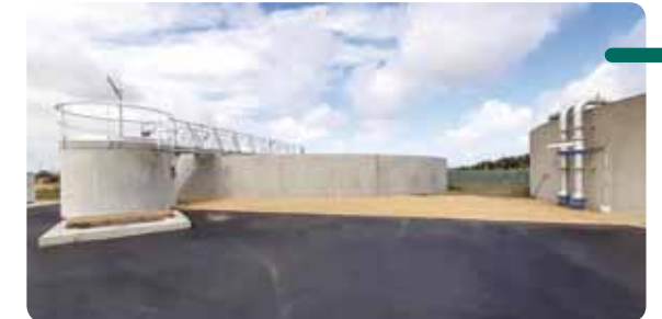
Nouveau bassin tampon récemment construit.
