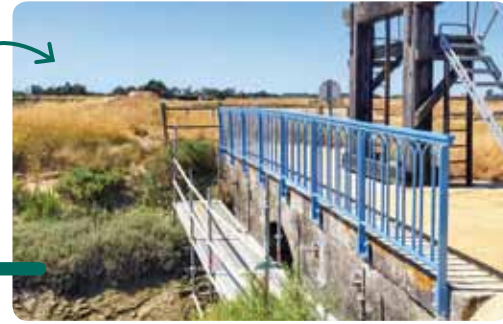
Enlèvement des modulaires utilisés lors des travaux du Groupe scolaire Le Gois
