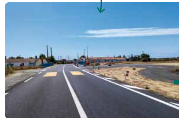
Travaux d'aménagement cyclable autour de l'écluse du Grand Pont par le département de la Vendée
