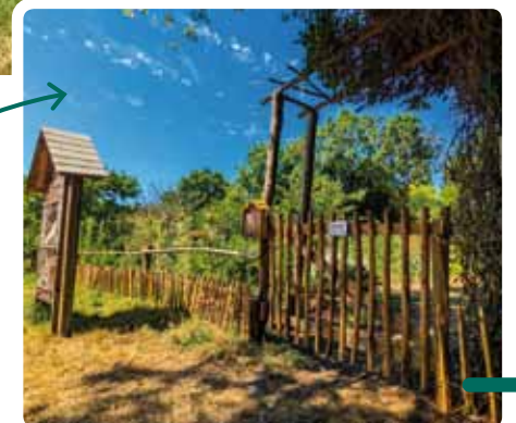
Mise en place de clôtures et portillons autour du Pot à Fleurs
