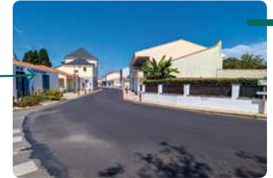
Travaux d'aménagement des extérieurs de la Bibliothèque - Ludothèque "Le 3"
