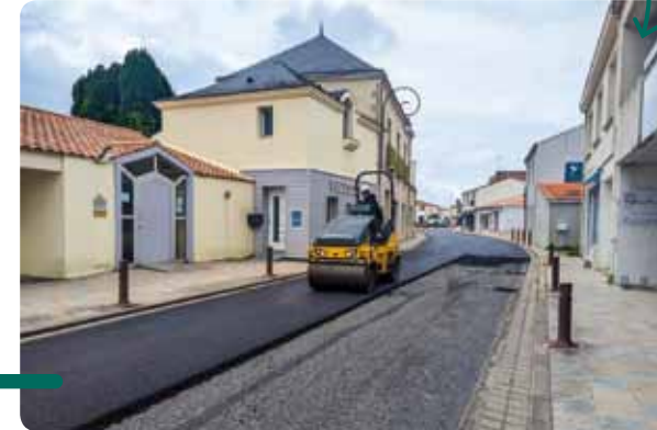
Poursuite des travaux de réaménagement du centre-bourg
