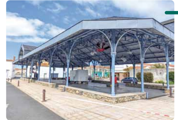
Rénovation en cours de la charpente métallique des Anciennes Halles.
