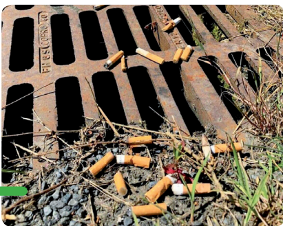
Des mégots de cigarette à proximité d'un avaloir d'eau pluviale
