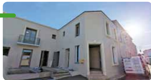
Une partie de la façade de la Résidence Billon, depuis la Grand Rue, pendant les travaux.
