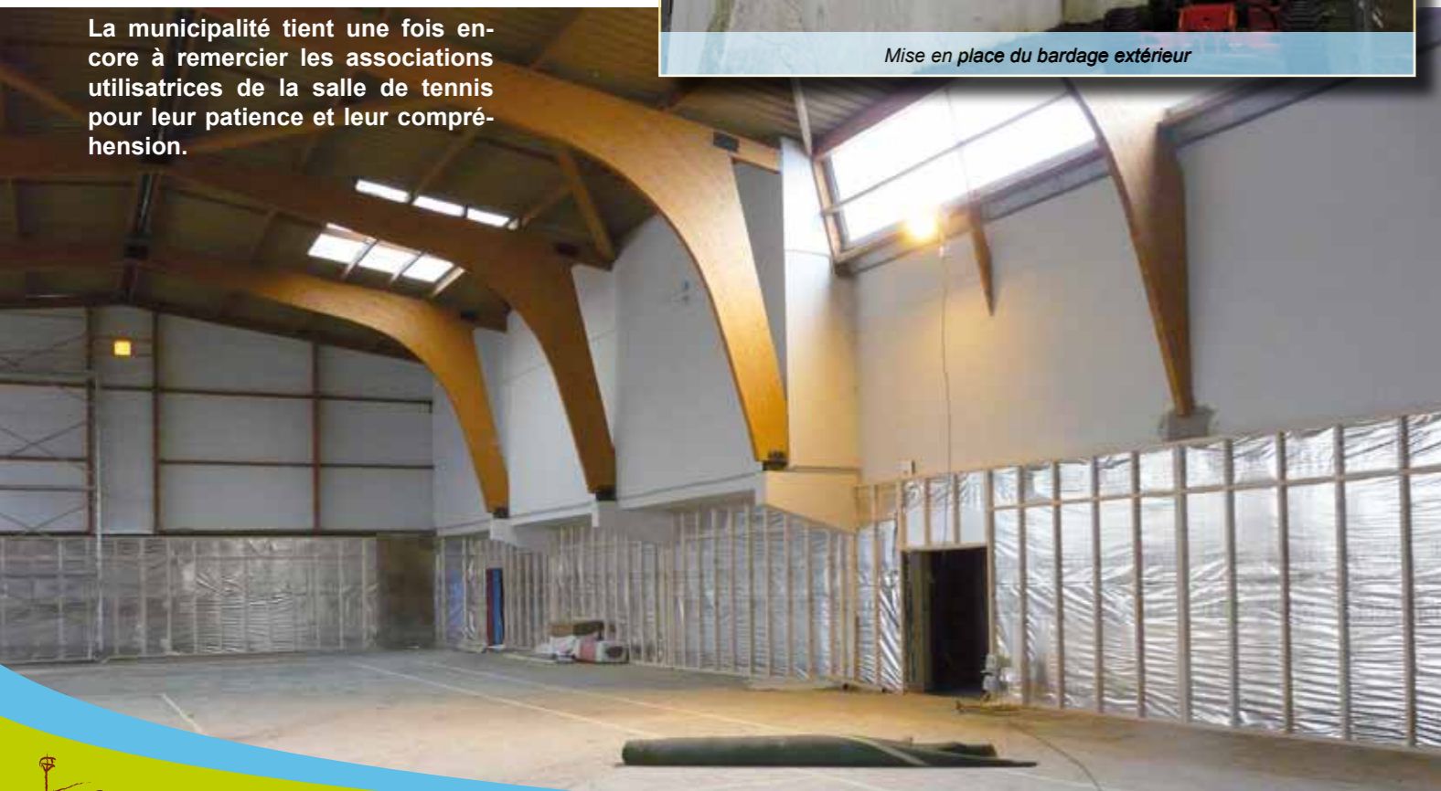
Installation de l'isolation intérieure
