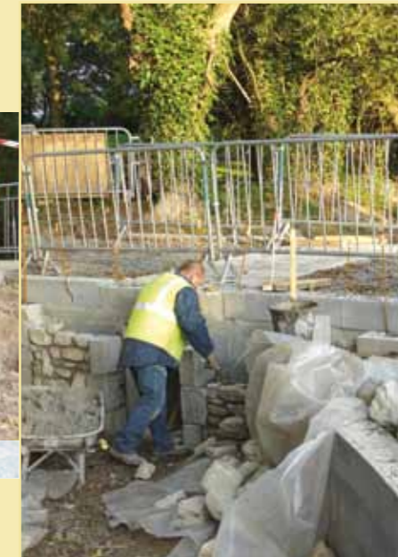
Petit pont en cours de construction
